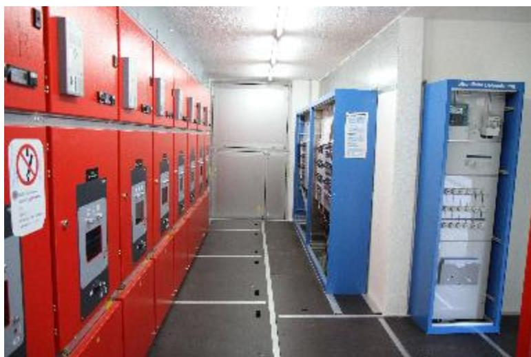
Das Bild zeigt auf der linken Seite die neue Hochspannungsanlage (rot) und rechts die Niederspannungsverteilung sowie die Verteilung für die öffentliche Beleuchtung
