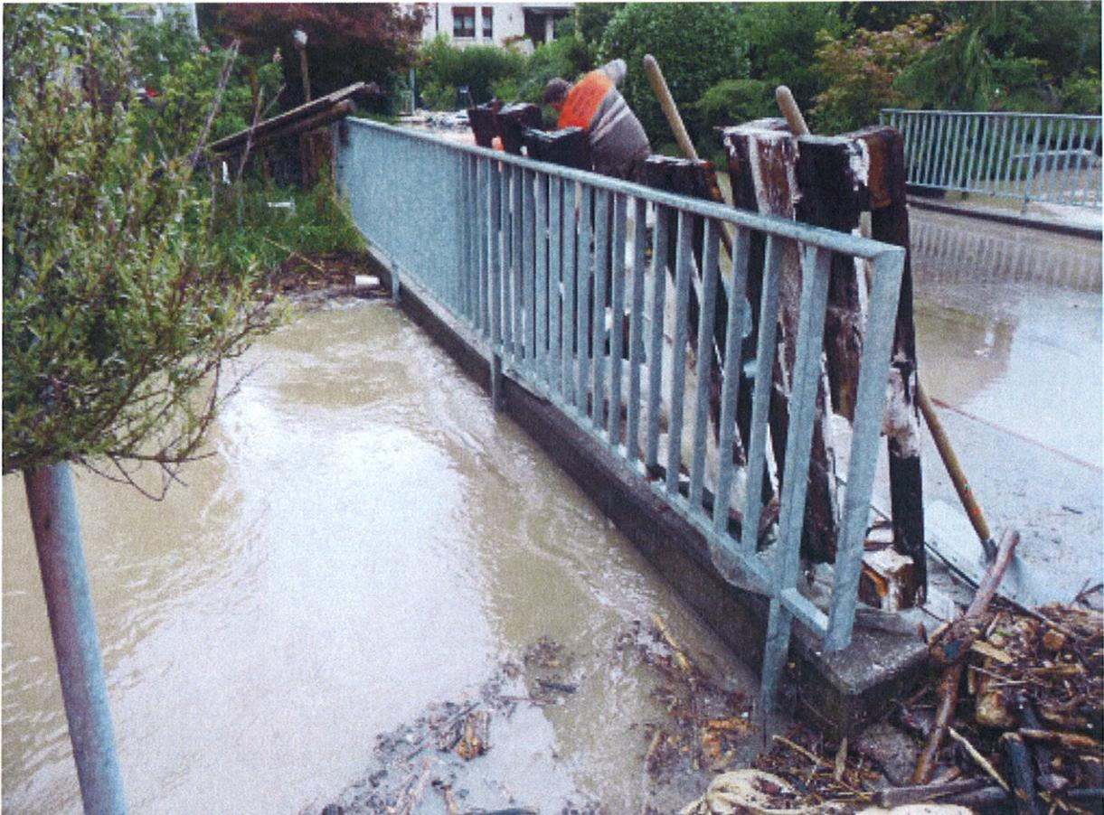
Abb. Nr. 4 Die Brücke Schiltstrasse bildet eine massgebende Schwachstelle bezüglich Hochwasserabfluss (Ereignis August 2010)
