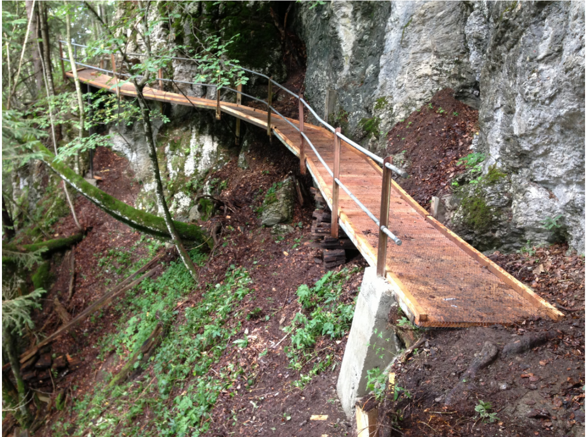
Der frisch sanierte Steg beim Nidelweg am Freitag der vergangenen Woche.
