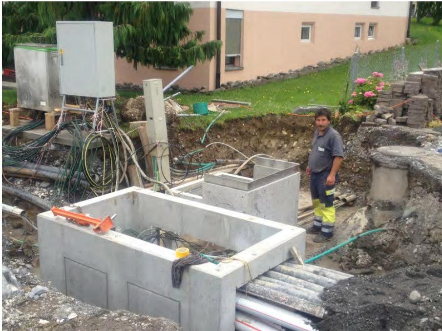
Für die Erneuerung und Erweiterungen von Netzen wenn immer möglich in Zusammenarbeit mit den anderen Werken WV, AW, Strassensanierungen. Für den Ersatz von Verteilkabinen müssen oft, wie hier in Biltlen, umfangreiche Bauarbeiten getätigt werden. Hier wird eine Verteilkabine für EW und Cablecom erneuert. Dabei darf es für die Kunden jeweils nur kurze Unterbrüche geben.
