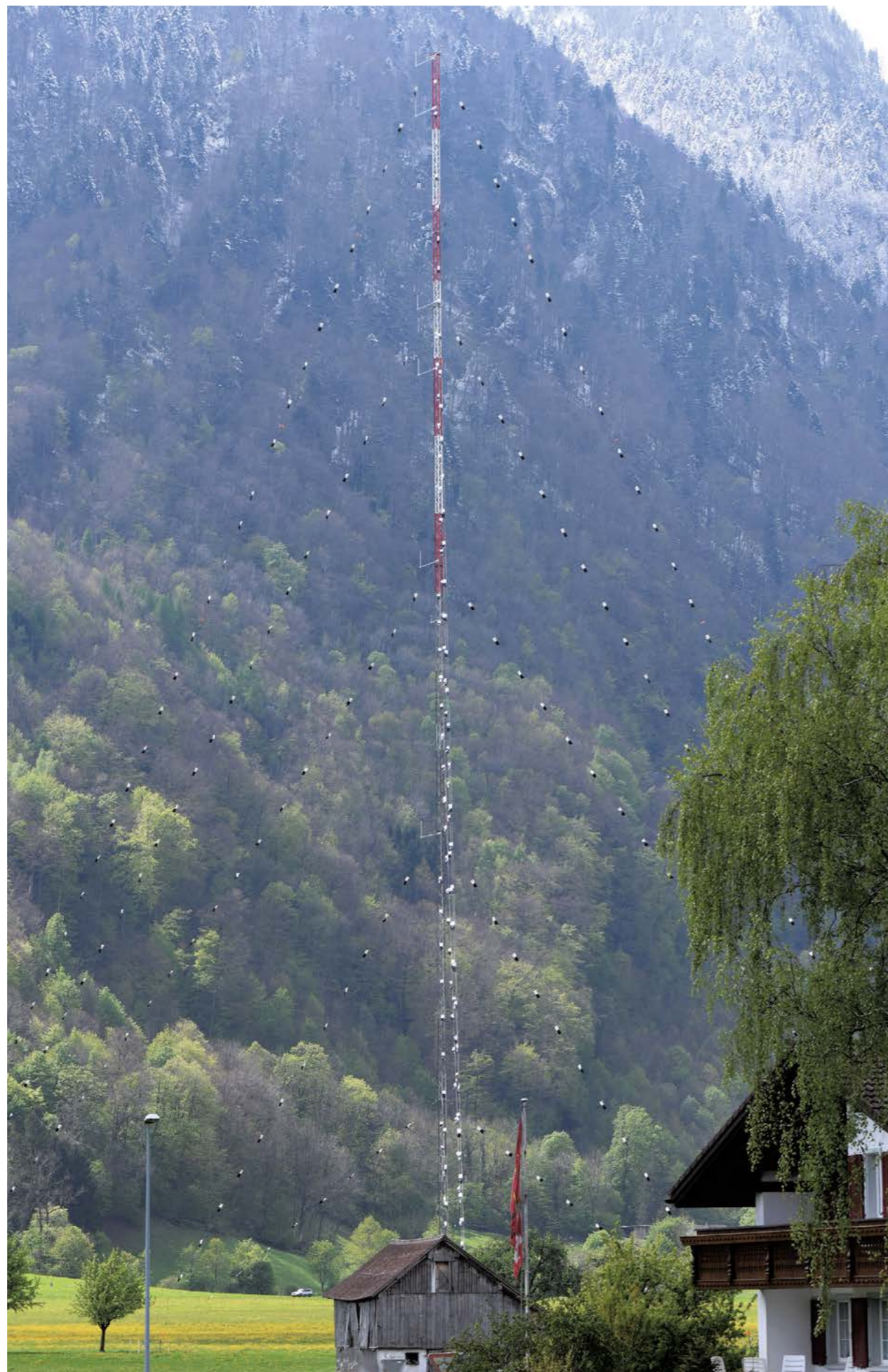
Messanlage der SAK zur Umweltverträglichkeit von Windkraftanlagen auf dem Boden der Gemeinde Glarus Nord.
