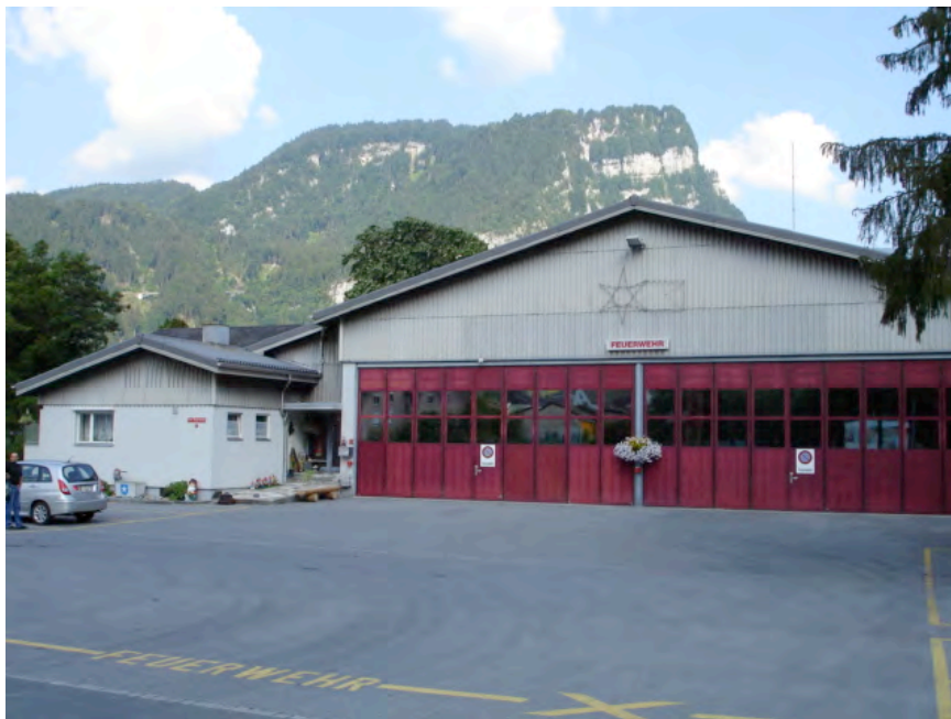
Feuerwehrdepot Mollis, Ansicht Seite Rüfistrasse
