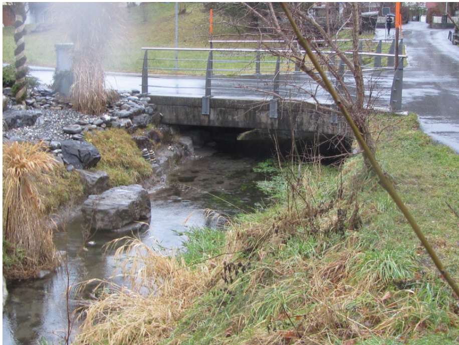
Bild 2: Tiefliegender Steg der Rütelistrasse über den Rütelikanal
