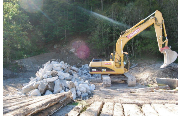
Rückbau Schiessanlage Oberurnen
