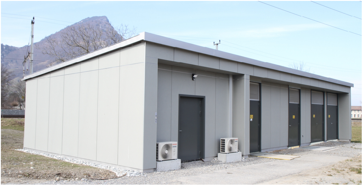
Die total sanierte Mess-Station Frühatzung mit dem Kommunikations-Knoten
