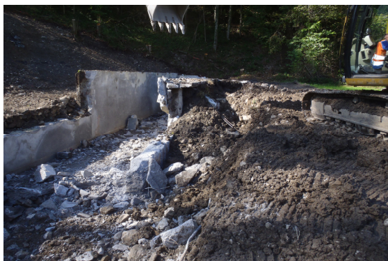
Rückbau Schiessanlage Oberurnen
