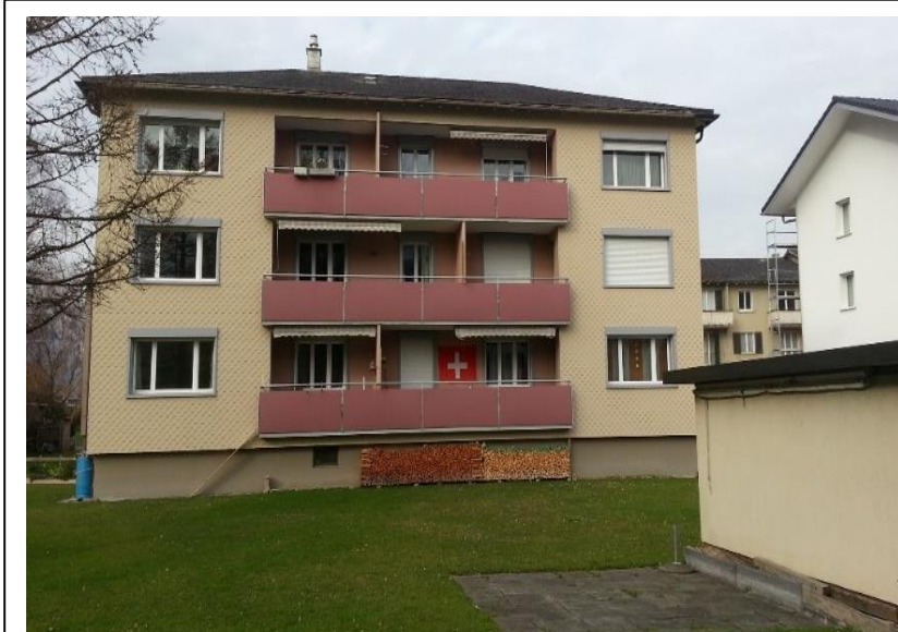
Ansicht Fassade nordwestlich
