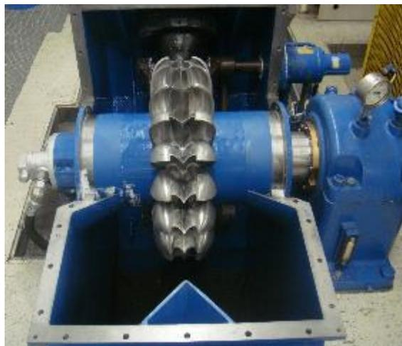
Das Ende der Laufzeit des Pelton-Turbinenrads der Bachwasserturbine in Niederurnen wurde erreicht und das Rad musste ersetzt werden
