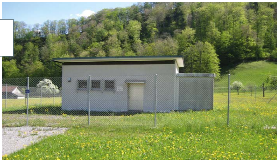
Grundwasserpumpwerk Feld Niederurnen – 2013 erneuert
