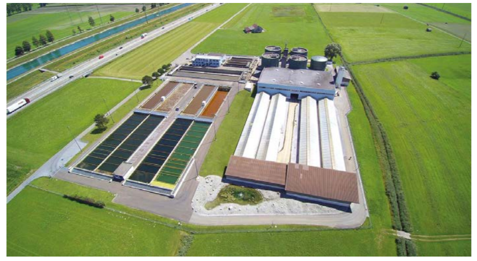
Die Anlagen der ARA Glarnerland im Überblick
