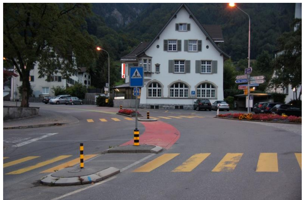
Abbildung 6: Mollis, Kreuzung Bahnhofstrasse, Kerenzbergstrasse, Vorderdorfstrasse, Hinterdorfstrasse. Der rote Streifen kann von links abbiegenden Velofahrern genutzt werden (beide Fahrrichtungen).
