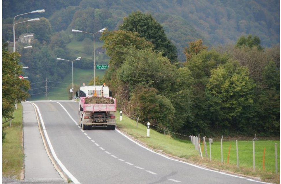
Abbildung 35: Flechsenstrasse, Überführung über Verbindungsstrasse zur A3. Eingeschränktes Platzangebot für den Langsamverkehr. Der MIV verkehrt mit relativ hohen Tempi.
