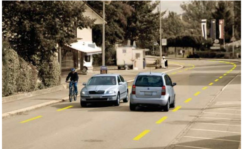
Abbildung 18: Beispiel einer Kernfahrbahn im Kanton Aargau. Motorfahrzeuge dürfen für das Kreuzen auf den Radstreifen ausweichen, sofern keine Velofahrer behindert werden. (Quelle: Kanton Aargau, www.ag.ch )
