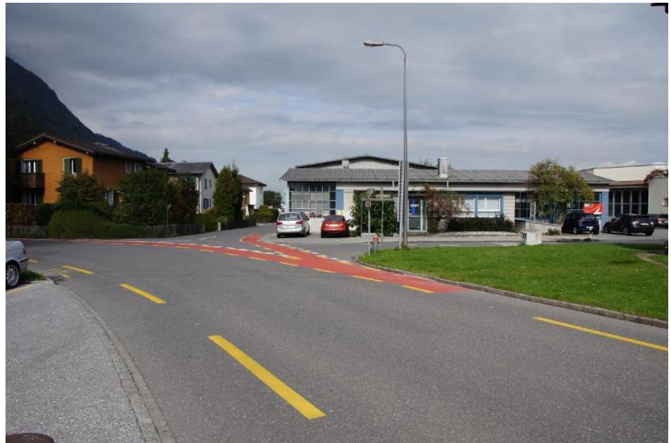
Abbildung 7: Rot eingefärbte Radstreifen, um die Aufmerksamkeit abbiegender Automobilisten auf den Langsamverkehr zu lenken. Niederurnen, Wiesenstrasse und Brunnenstrasse.
