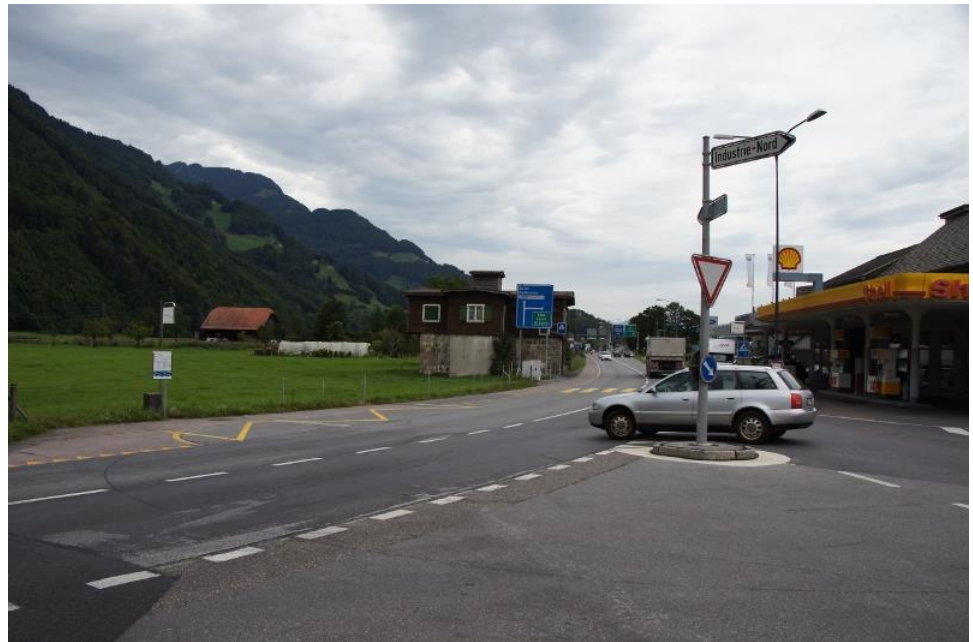
Abbildung 12: Näfels, Verzweigung Kantonsstrasse, Ausschachen, Kleine Schwärzistrasse. Ende des Radwegs mit anschliessender Querung der Fahrbahn für den Veloverkehr. Die Sicht nach hinten ist durch das braune Gebäude eingeschränkt.
