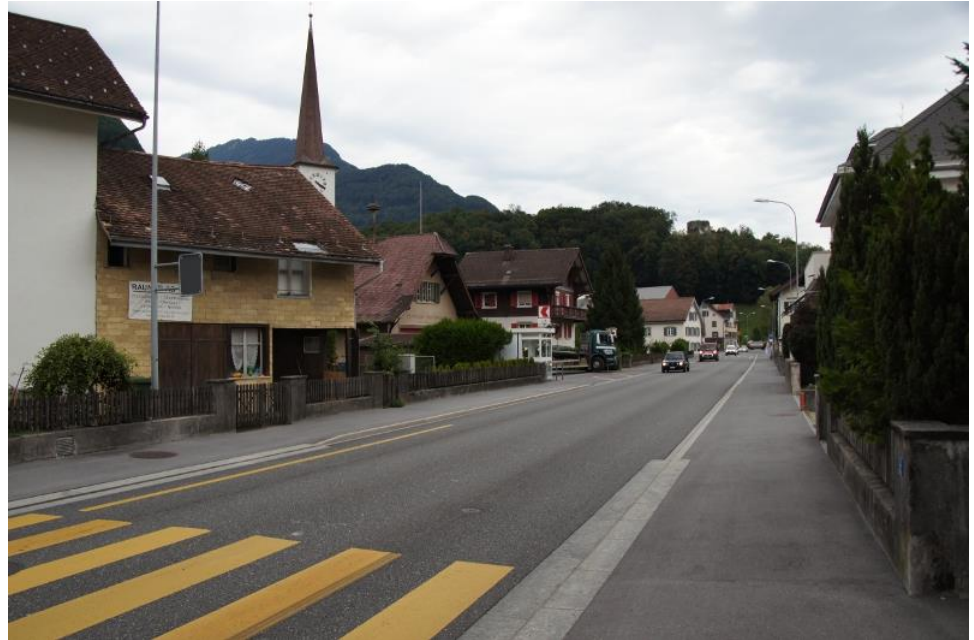
Abbildung 27: Ortsdurchfahrt Oberurnen. Das Platzangebot ist beschränkt. Strassenbreite ca. 6m (Fahrbahn).
