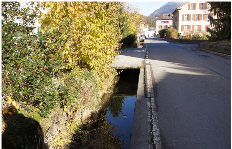
Abbildung 33: Kanalisiertes Gewässer in Oberurnen, das in seiner Charakteristik aus ortsbaulicher Sicht zu erhalten ist. Der Gewässerraum ist auf die Gewässeroberfläche zu reduzieren.
