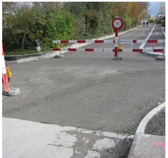
Gemeindestrassen mit Oberbau und Unterbau
