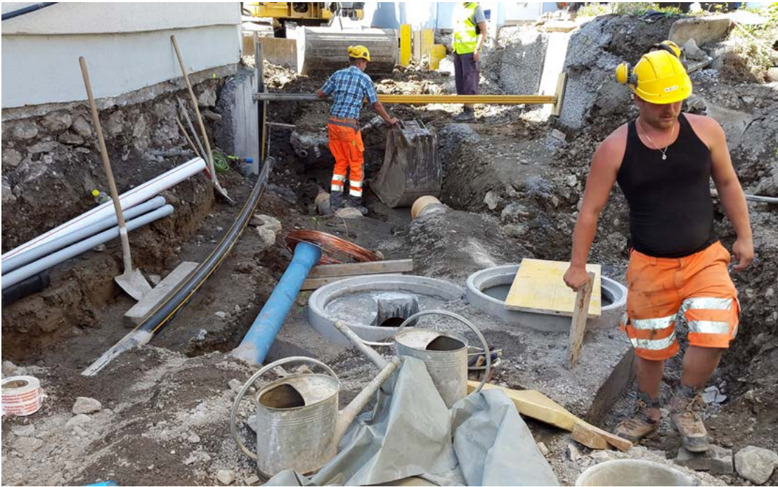
2 von 3578 Normschächten in der Gemeinde Glarus Nord
