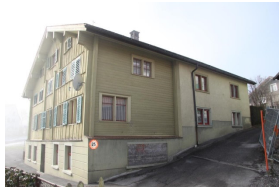
Abb. 6: Östliche Giebelseite und nördliche Traufseite. Gut sichtbar die charakteristischen Pfettenkonsolen und Pfettenköpfe.
