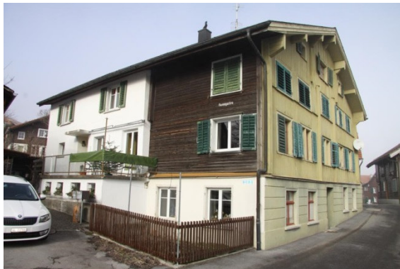
Abb. 5: Südliche Trauffassade und östliche Giebelfront gegen die Dörflistrasse.
