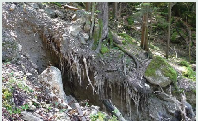
Beim unterspülten Baum sieht man die weit verzweigten Wurzeln auf eindruckliche Weise.
