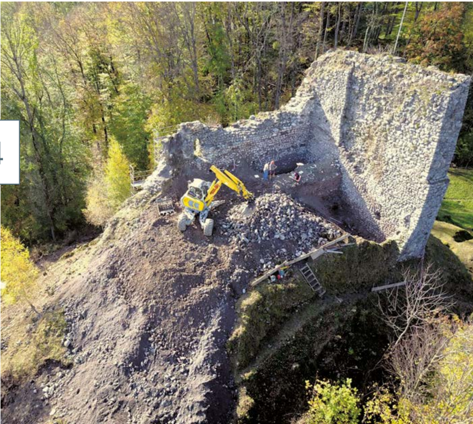
Baustelle im Oktober 2017. (Foto Christian Bader)
