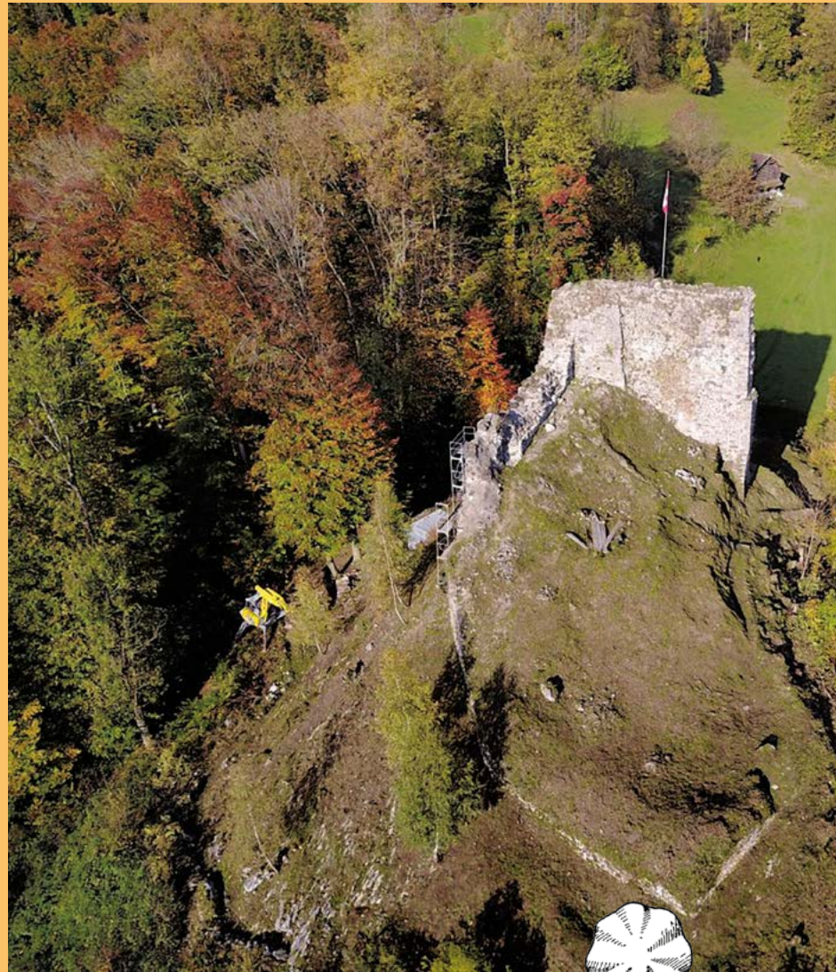
Der Schreitbagger (unten links) ist im Anmarsch, um die Schuttmassen im Burginneren zu entfernen. (Foto Christian Bader)
