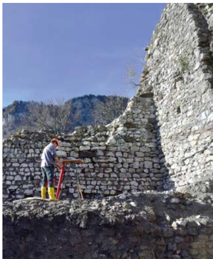
Christian Bader bei der Vermessung der neu freigelegten Binnenmauern. (Foto Steve Nann)
