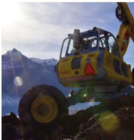
Baggerführer Lothar Gut am Werk. (Foto Steve Nann)
