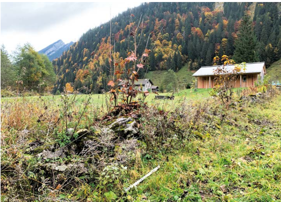
Die Trockenmauern rund um das Freibad Obereestafel sollen in diesem Jahr saniert werden.
