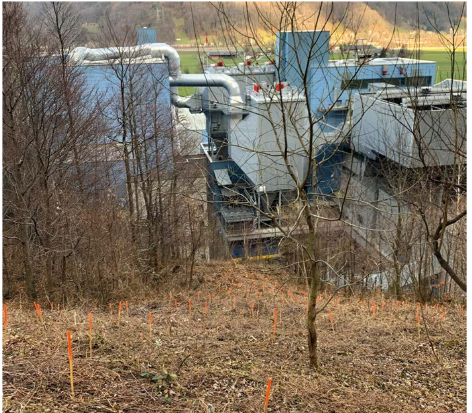
Beispiel eines vom Neophytenbefall bekämpften Waldabschnitts hinter der KVA Linth zwischen Bilten und Niederurnen.
