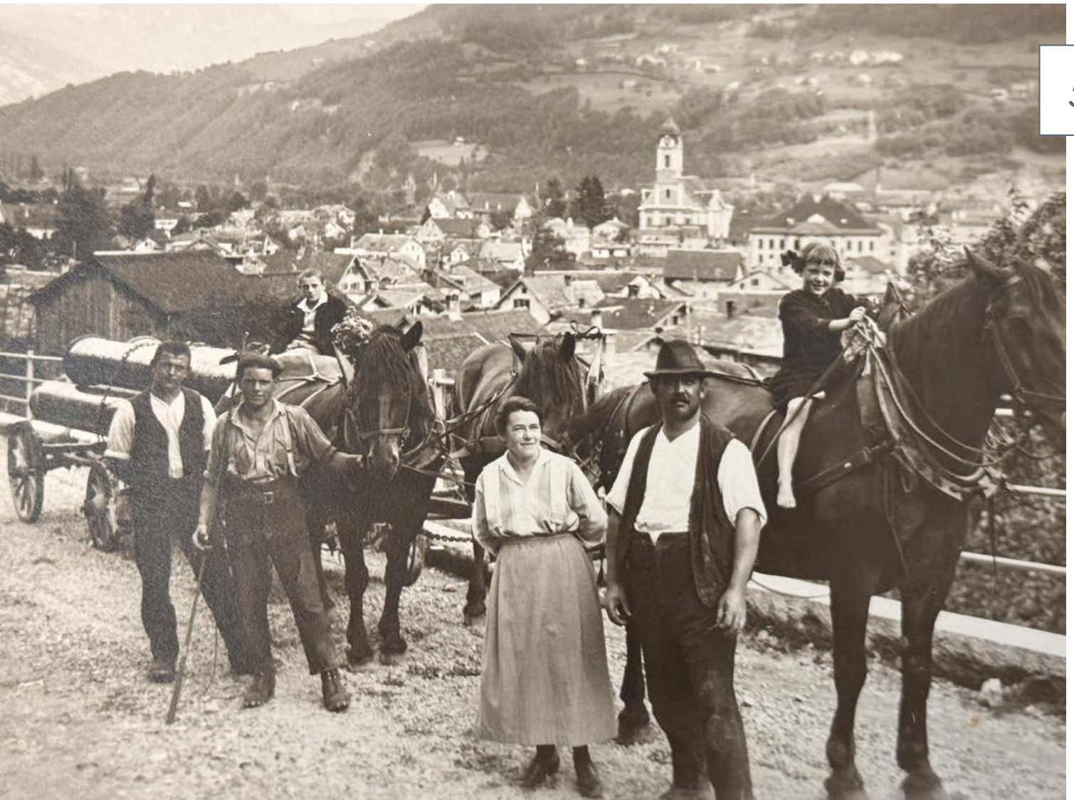
Die Rohre für die Druckleitung zwischen Rütiberg und Risi werden transportiert (Aufnahme vermutlich von 1924).
