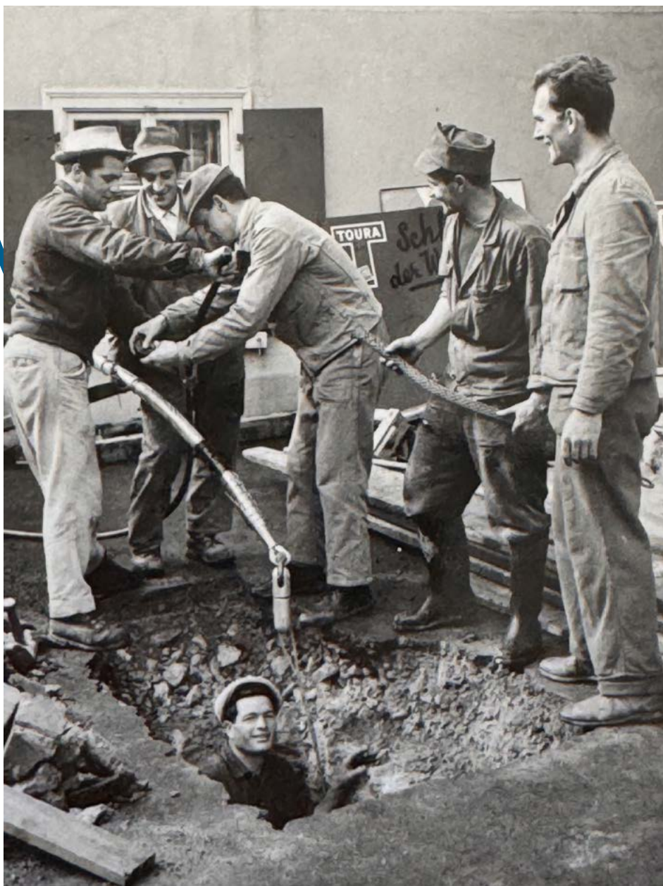
Arbeiter bei der Rütiberg-Risi Erweiterung.
