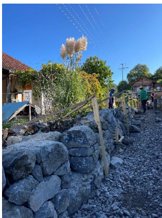
Bildlegende: Trockenmauersanierung in Filzbach durch Zivildienstleistende der SUS.
